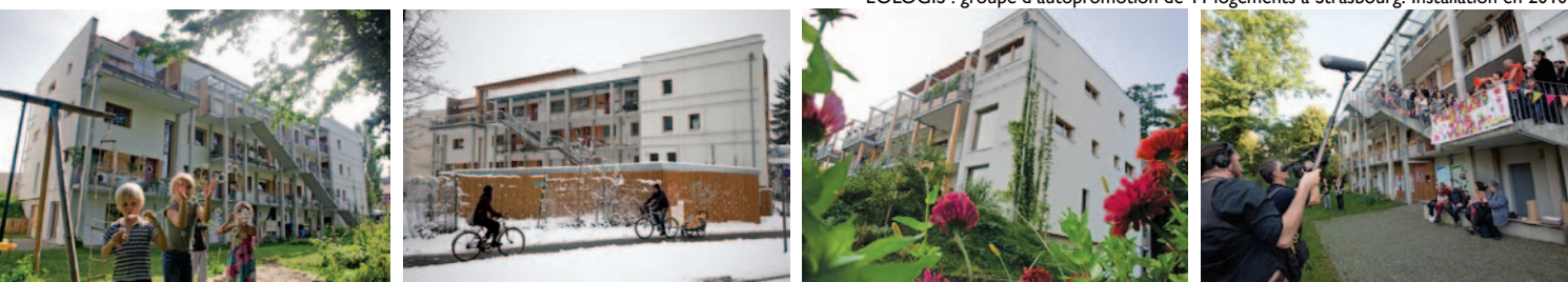
EOLOGIS : groupe d'autopromotion de 11 logements à Strasbourg. Installation en 2010
